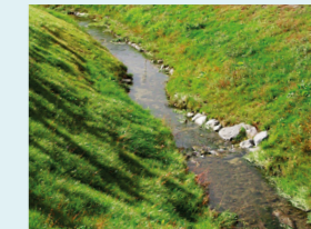
Schlechtes Beispiel: Obwohl der Bach renaturiert wurde, kann er seine ökologische Funktion kaum wahrnehmen. Durch die fehlende Beschattung wärmt sich das Wasser stark auf und die Gewässersohle verschlammte durch übermäßigen Algenwuchs im Sommer. Für die Fische fehlen wichtige Unterstände.
