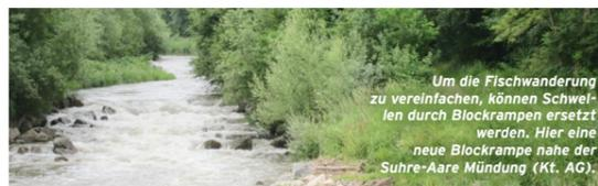
Um die Fischwanderung zu vereinfachen, können Schwellen durch Blockrampen ersetzt werden. Hier eine neue Blockrampe nahe der Suhre-Aare Mündung (Kt. AG).
