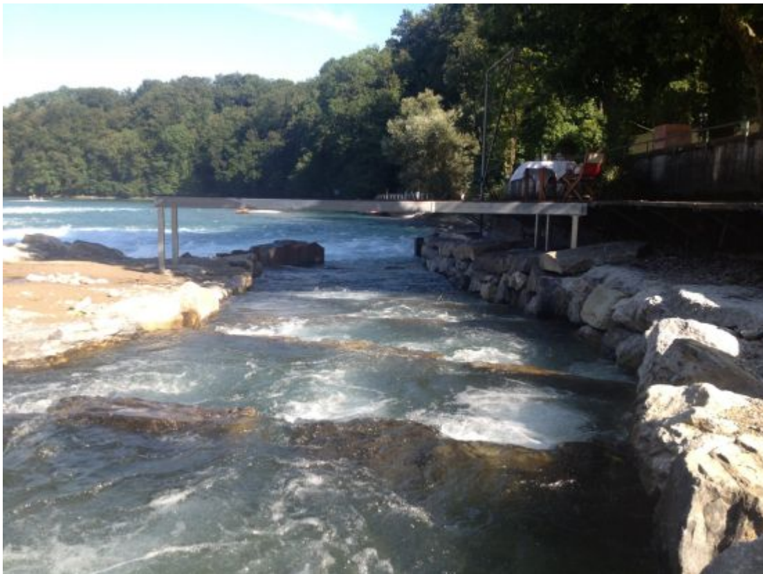
Fig. 2: Les passes à poissons permettent le franchissement des ouvrages hydroélectriques vers l'amont. Des grilles et des systèmes de déviation aident à protéger les poissons des turbines lors de la dévalaison.
