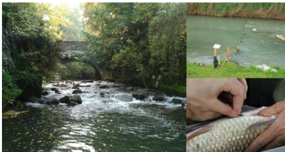
Figure 2 : L'une des rampes en enrochement étudiées dans la Pfaffneren (à gauche), une antenne (en haut, à droite) permettant de détecter le passage des poissons marqués à l'aide d'émetteurs PIT (en bas, à droite).
