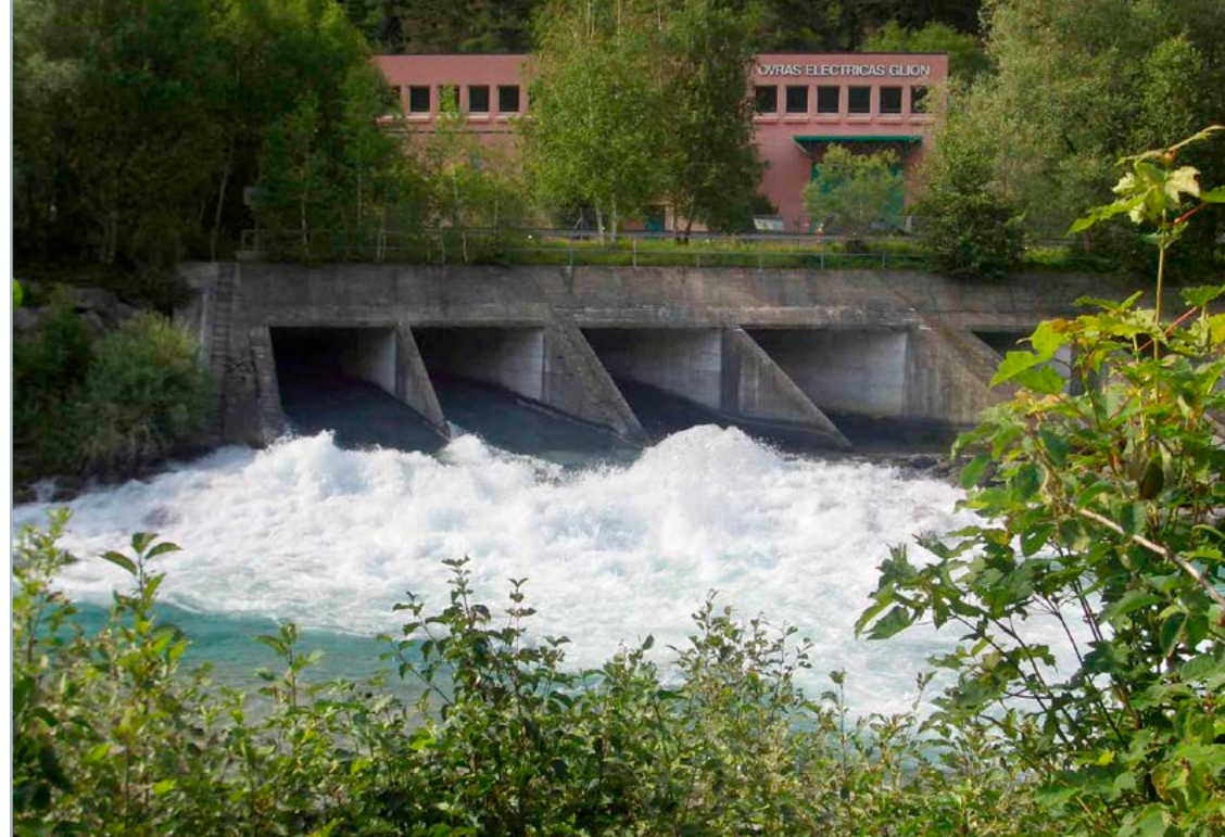
Figure 12: écluse sur le Rhin à Illanz. Photo: Armin Peter.
