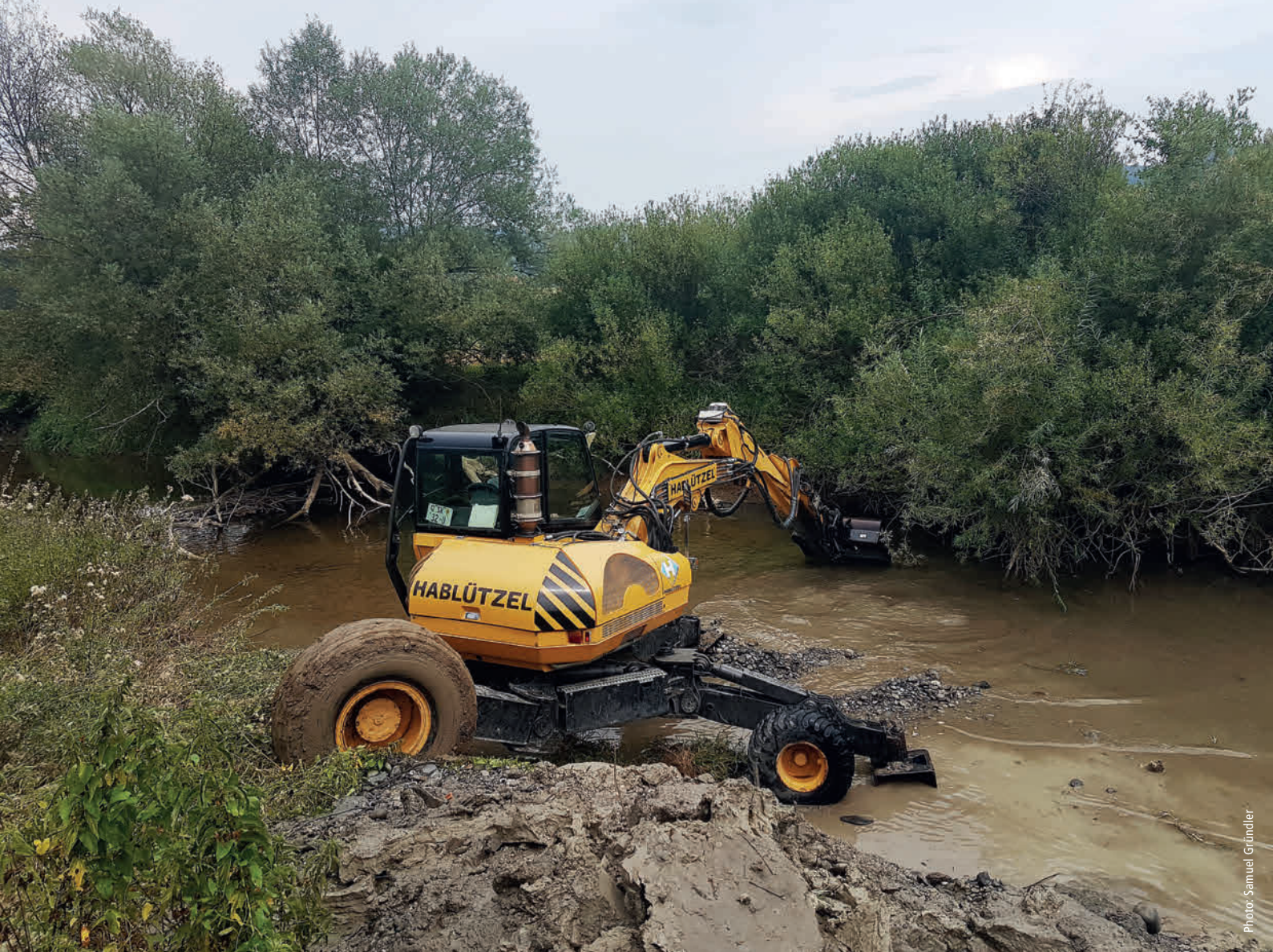
▲ Creusement d'un affluent du Rhin pour créer une zone d'eau fraîche et profonde
