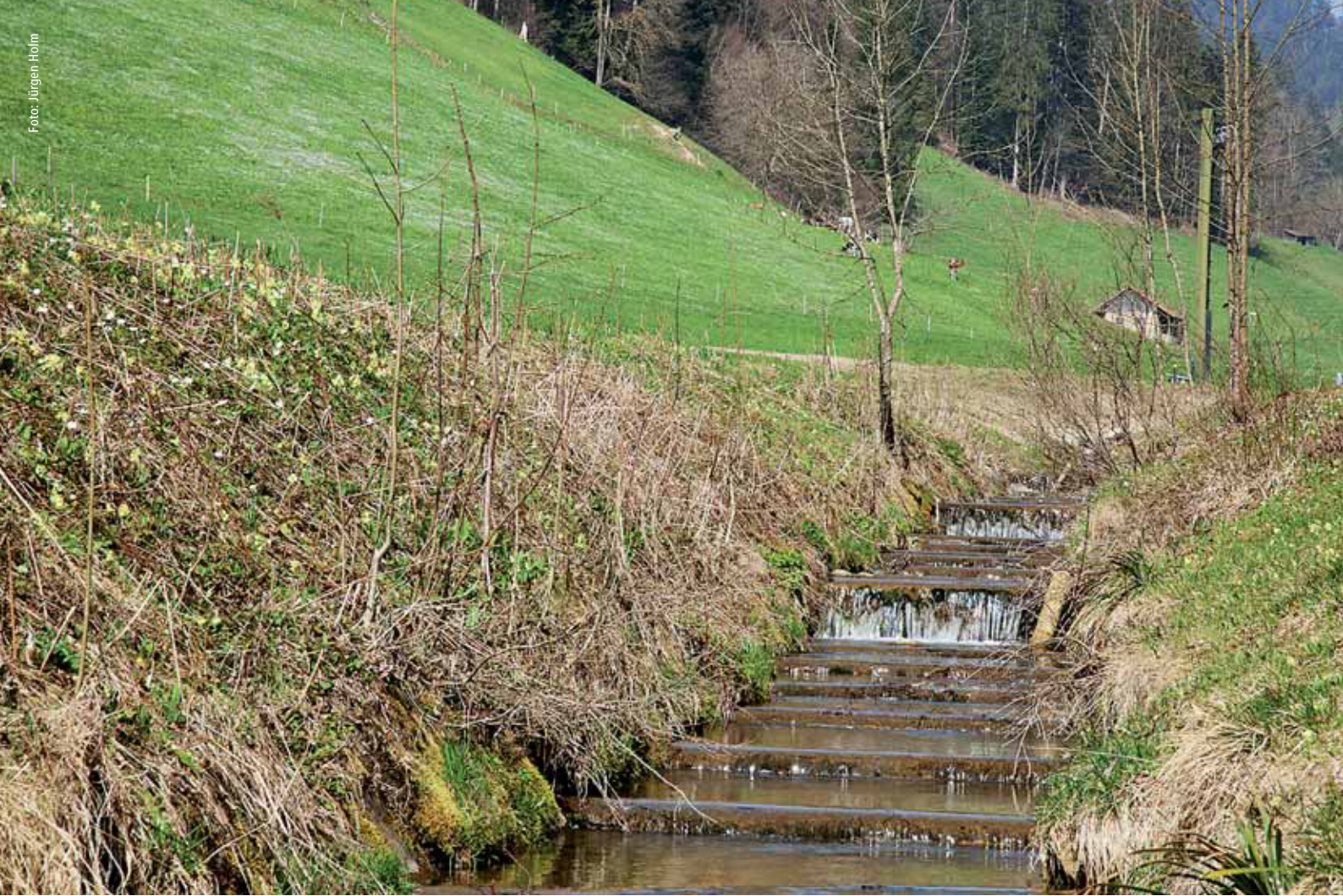
▲ Abbildung 2: Querverbauungen im Frittenbach (BE) – ein Beispiel für die schlechte Gewässermorphologie vieler Schweizer Bäche.
