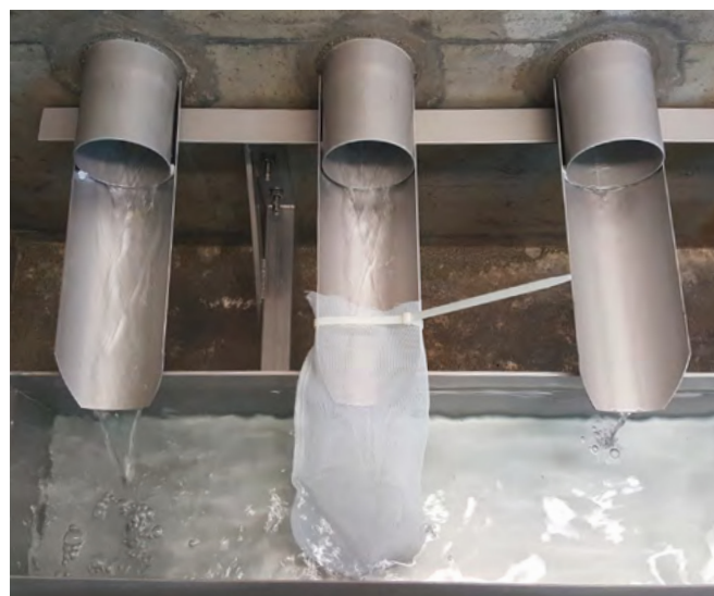
Captage d'eau potable équipé d'un filet, permettant de capturer les amphipodes des eaux souterraines. Photo: Nicole Bongni / amphipod.ch
