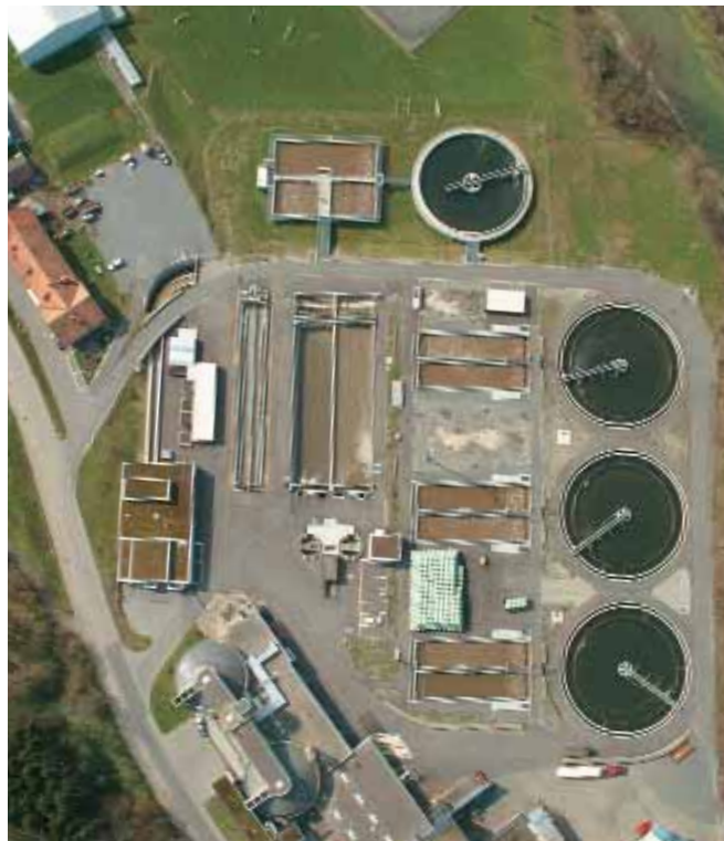
Abwasserreinigungsanlage St. Gallen Au. Foto Entsorgungsamt der Stadt St. Gallen
