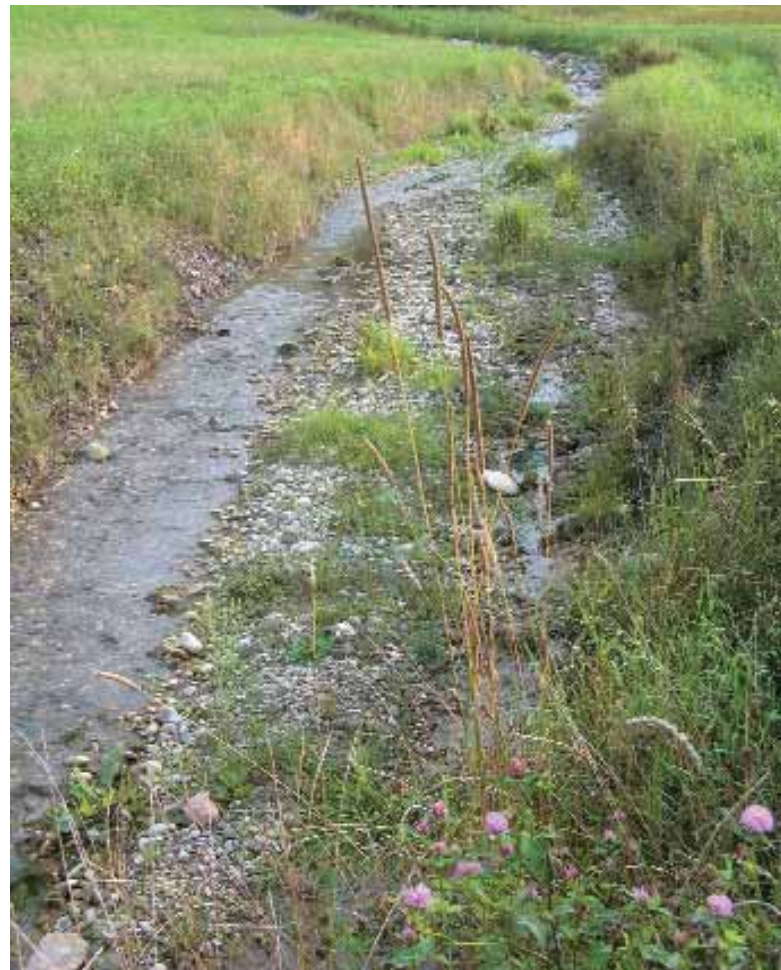
Ausdolung des Riedgrabens, BE: Minimieren des Hochwasserrisikos. Foto RenF / R. Stucki
