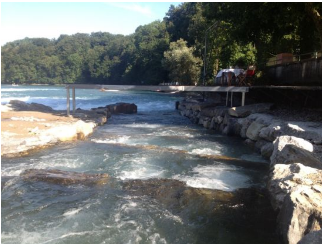
Abb. 2: Fischpässe ermöglichen Fischen an Kraftwerken die Wanderung flussaufwärts. Feinrechen und Umleitungssysteme schützen sie bei der Abwanderung vor den Turbinen.
