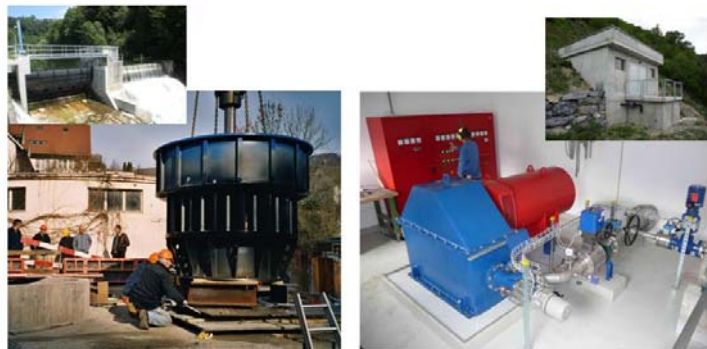
600 kW mit Niederdruck: 6 m, 12'000 l/s, ... 600 kW mit Hochdruck: 820 m, 80 l/s ...
