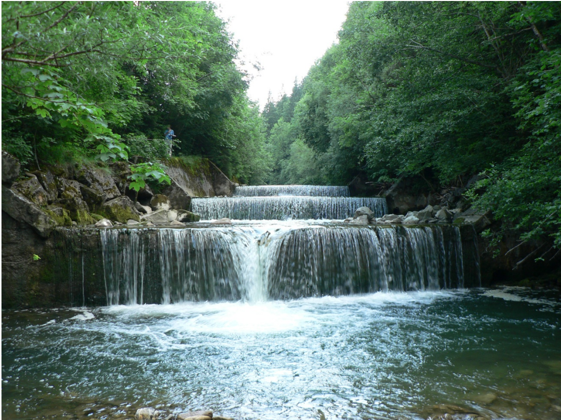
Abb. 1 : Schwellen an der Warmen Sense bei Zollhaus
