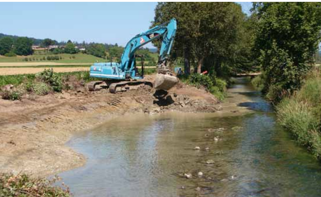
Fig. 8 Travaux de revitalisation à la pelle mécanique sur la Wyna à Gontenschwil AG.
