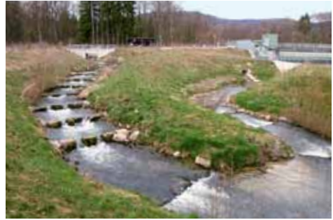
Fig. 14 Cours d'eau de contournement sur l'Aar au niveau du barrage de Schönenwerd SO. Photo: Armin Peter
