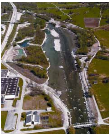
Fig. 9 La Moesa à Grono GR avant (au-dessus) et après les travaux de revitalisation (au-dessous). Le projet, réalisé sur un tronçon de 600 m de long, a coûté un peu moins d'un million de francs.
