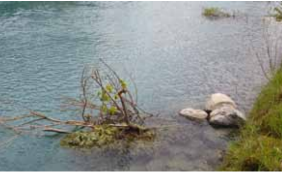
Photo au-dessous: A l'instigation d'un pêcheur, des interventions ont été menées dans l'Aare à Ringgenberg – remblai de graviers, arbres morts (fagots de branches) – pour recréer des habitats propices au frai et au grossissement des ombres. Les premiers contrôles effectués au printemps 2010 ont montré que les nouveaux habitats étaient déjà adoptés par les géniteurs. Près des berges, à l'abri des fagots de branches, une forte augmentation de l'éclosion des larves d'ombre a été constatée.
